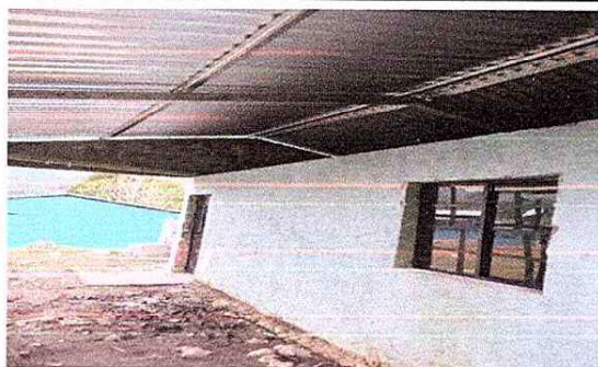
Foto 3: Sustitución de lamina de direccion y rehabilitación y ampliación de paredes.
